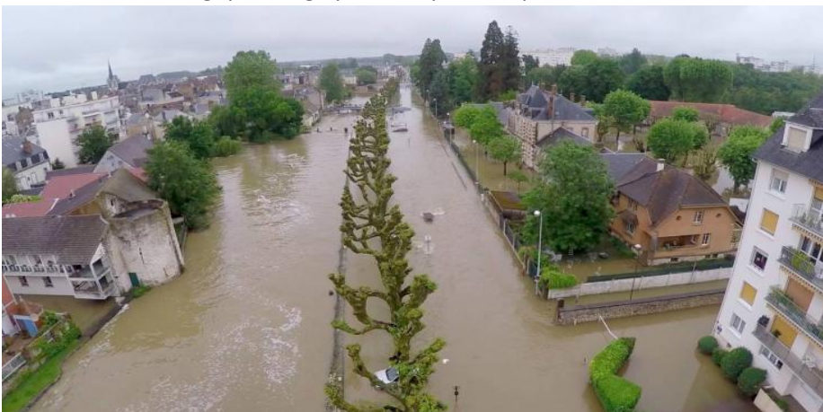
Montargis – inondations juin 2016 (© préfecture du Loiret – BPDC)
